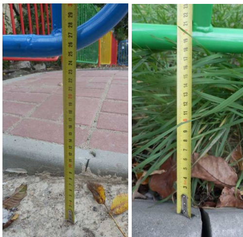
Фиг. 4. Реалните разстояния между оградната конструкция и настилката.
