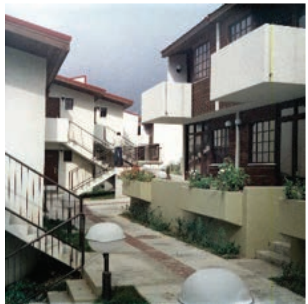
Фиг. 16. Ваканционно селище „Елените“, 1985; Архитекти: Стефан Орозов и Стойчо Велковски (А,Б – жилищни квартали, В – обществено-обслужващ център, Г – търговски център, Д – паркинги, Е – спортен комплекс, Ж – мотел, З – ресторант „Таяна“, И – администрация, К – детски анимационен център, Л, М – плажове, Н – сауна, О – река)
