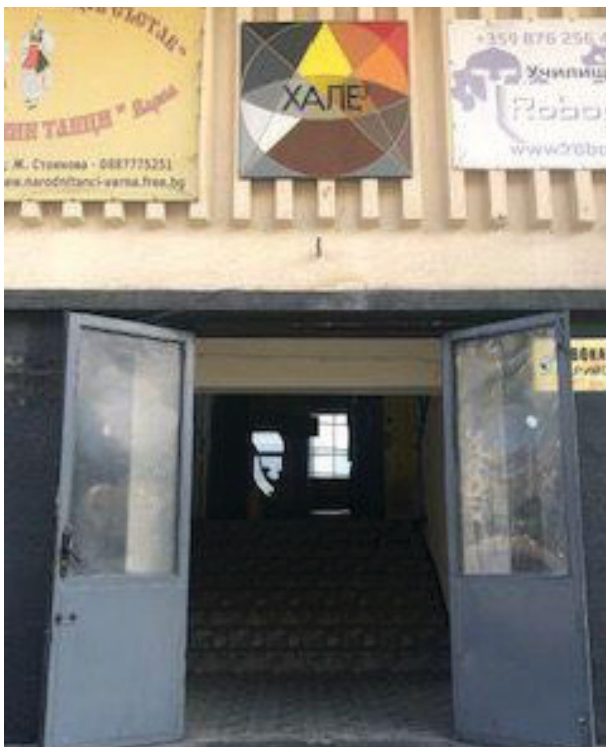
Фиг. 6. Главен вход на бившата Полиграфия с изглед към „Хале 3“ (2023) Източник: Собствена снимка
