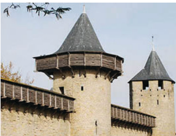
Фиг. 23. Пример за дървена надстройка над крепостна стена (15)
